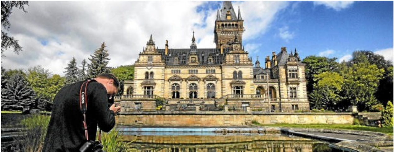
Das Jagdschloss in Hummelshain im Saale-Holzland-Kreis kann weiter saniert werden. Foto: Dieter Urban
